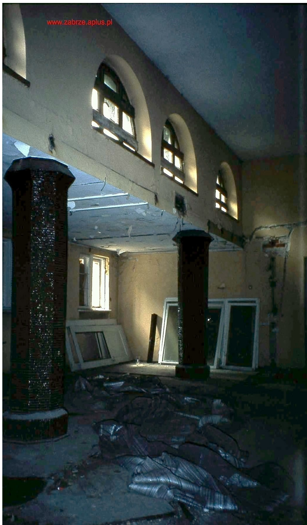
Zdj 6. Hala główna. Interesujące rozwiązanie z kolumnami. Foto
